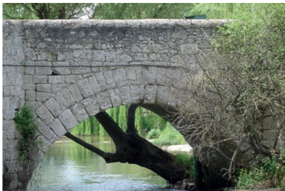
Fig. 5. Arco 2.º, aguas arriba, de Agustín de Zorlado, 1670-1676. Véanse las dovelas de doble rosca (fotografía del autor, 2005).
