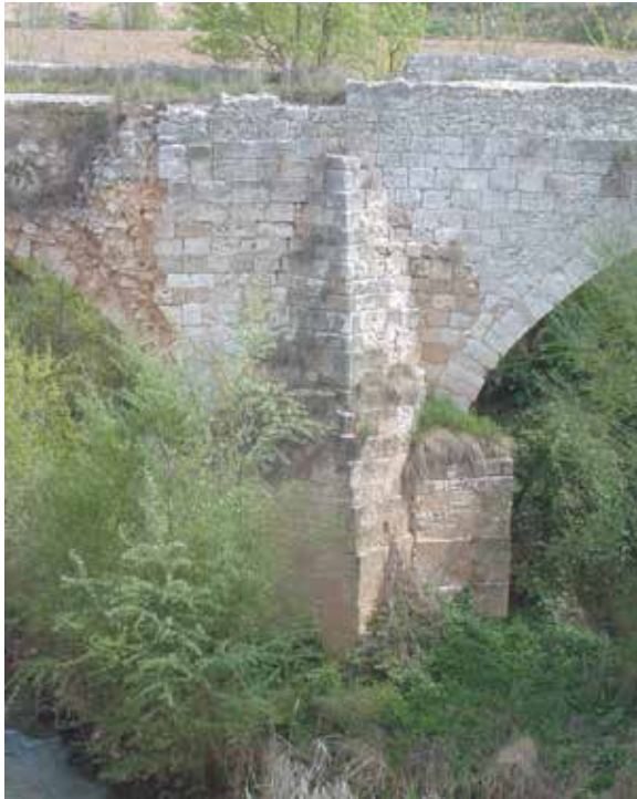
Fig. 4. Espolón escalonado del tercer pilar, gótico (fotografía del autor).
