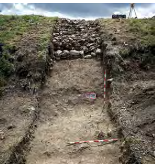
Vista de la muralla ataludada de El Cincho desde el camino histórico (en primer término).
